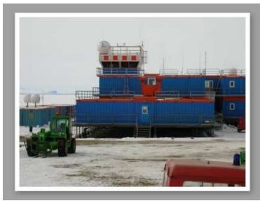
Corpo centrale della base con la Sala Operativa
