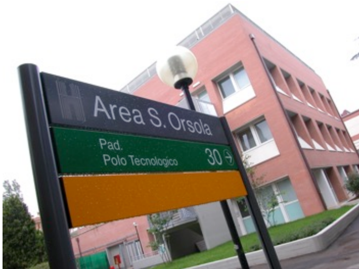
Il padiglione del Polo Tecnologico dell'ospedale S.Orsola-Malpighi di Bologna progettato e realizzato in base alle indicazioni e supervisioni di Carlo Bergamini.
