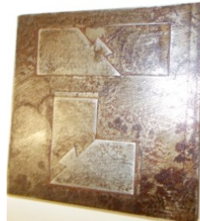
Placca con incastri a coda di rondine coperta di ruggine.
